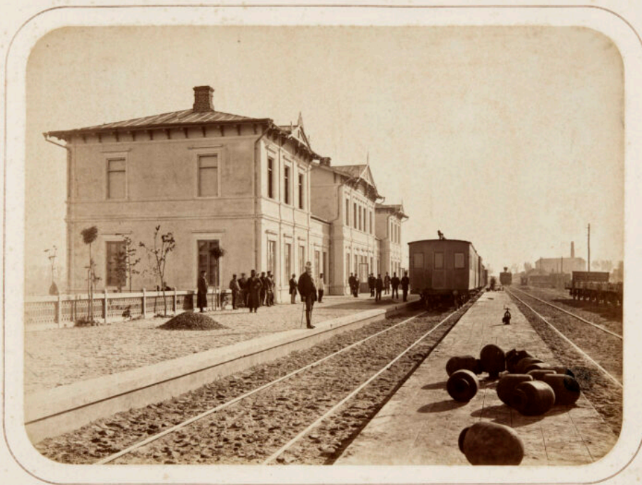
ПАССАЖИРСКОЕ ЗДАНИЕ II го КЛАССА НА СТ. ЛЮБЛИНЪ. [A] DOM PASAZERSKI KLASY II go NA STACYI LUBLIN.
